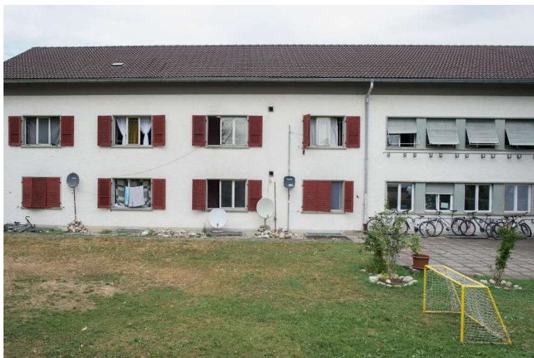
Das Zentrum in Aarwangen.
